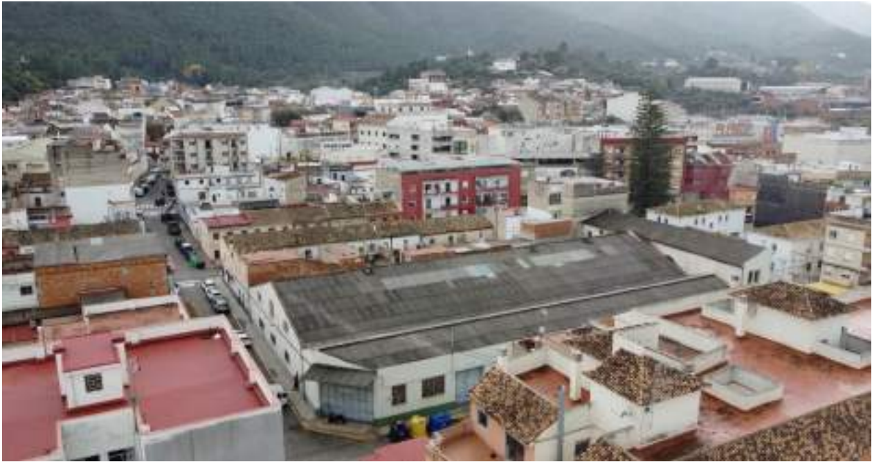
Figura 21: Vista aérea de la cubierta de Cooperativa Agrícola Nuestra Señora de la Fuente, Coop. V. - Fontcoop (Villalonga – Valencia)
